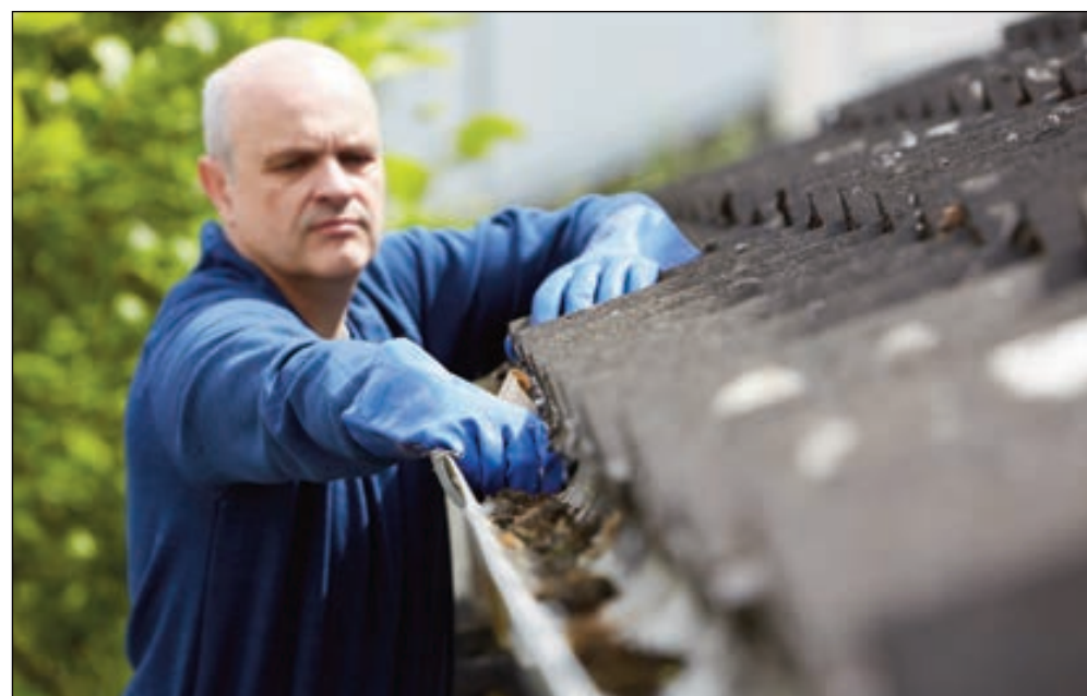
Tilstoppede tagrender skal naturligvis renses grundigt op, så vandet ikke løber over og ned ad husmuren mv. Foto: Ingimage.com
