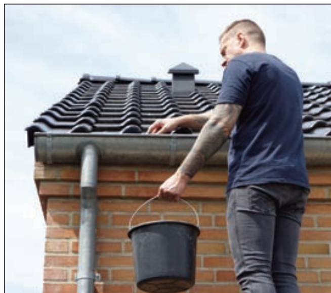
Tagrenderne skal gøres - og holdes - rene, inden efterår og vinter sætter ind. Foto: Kehlet
